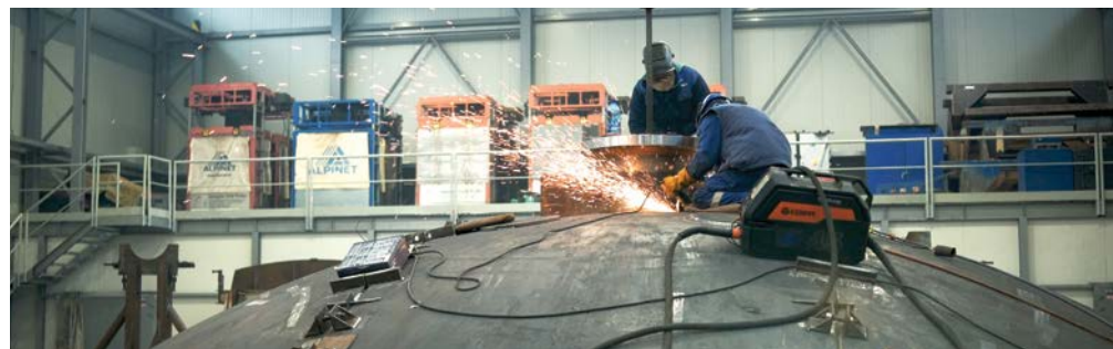
● Práce na vrchnej časti guľového zásobníka
