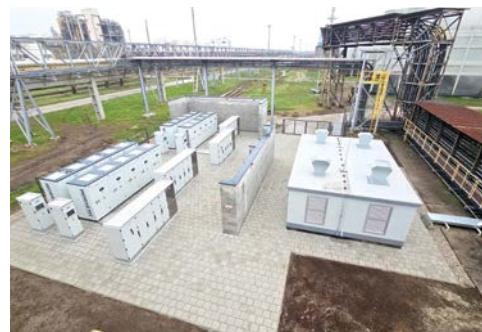
● Batériové úložisko
