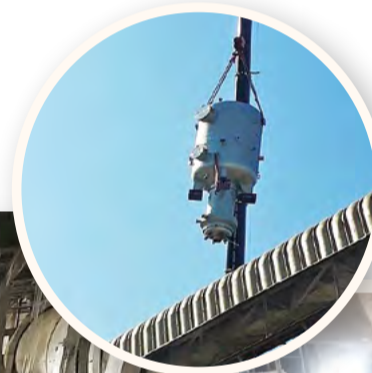
Montáž reaktora 101 na TN
